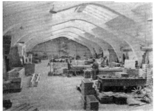
Interiør fra fabrikken
