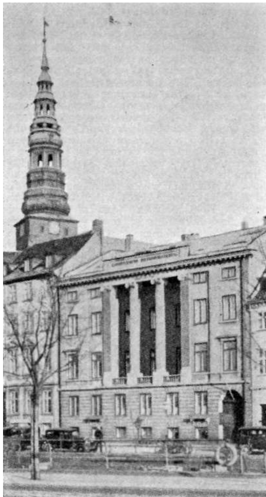
Kjøbenhavns Brandforsikrings ejendom Ved Stranden nr. 14
