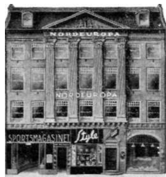
Forsikringsaktieselskabet Nordeuropa's bygning, Amagervej 11
