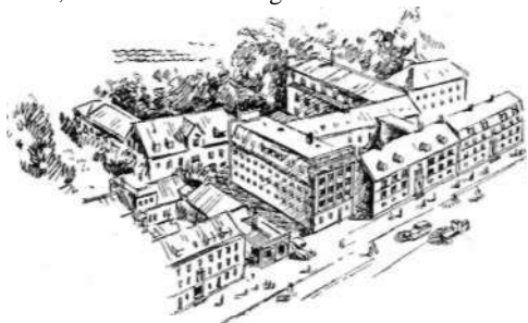
A/S Aibo-Bahrs bygninger på VodroHsvej
