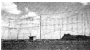
Retningsantenne med dipoler.
