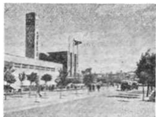
Bred alle med moderne bygninger i Ankara.
