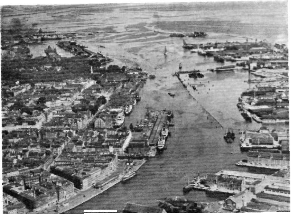
Den nordlige del af Københavns havn. Nederst t. v. Havnegade, Nyhavn og derpå Kvæsthusbroen m. DFDS's rutebåde. Inde i byen t. v. skimtes Amalienborg. Forneden t. h. det nordligste Christianshavn, i S e n t h en del af Holmen og oriogsværftet. I billedets midte: toldboden, for oven t. h. yderhavnen, m. Refshaleøen og Trekroner; t. v. ses kastellet, frihavnen og Langelinie.
