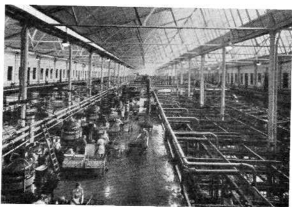
Ølaftapningshal på Carlsberg Bryggerierne. En af verdens største. 2 3 / 4 mill. flasker i døgnet.
