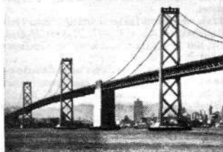
Hængebro. San Francisco-Oakland.
