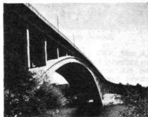
Buebro af jernbeton. Tranebergsbron, Stockholm.
