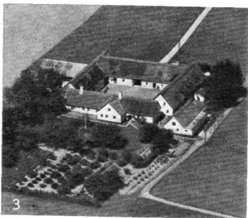
3 Firelænget moderniseret gård. Den fjernest liggende længe fra o. 1875 af kløvede sten. Underød, Egebjerg sogn i NV-Sjælland.
