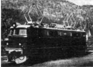
Svensk elektrisk lokomotiv. 2800 HK, 110 km pr. time.
