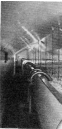
Gærkælder, rummer ialt 40 000 hl øl. Det gærende øl holder en temperatur på 7-9° C.
