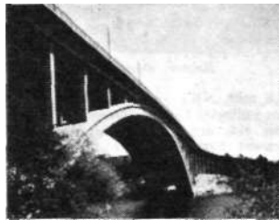
Buebro af jernbeton. Tranebergsbron, Stockholm.
