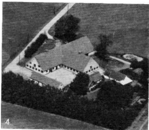
4 Moderne bondegård m. udlænger i T-form. Ledstrupgård, Egebjerg sogn i NV-Sjælland.
