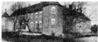
Anselig hovedbyggn. sydfløjen m. sandstensportal og hjørnetårne fra 1575, forringet ved ombygning i 18. årh., fredet i kl. A. Nu plejehjem for sindssyge.
